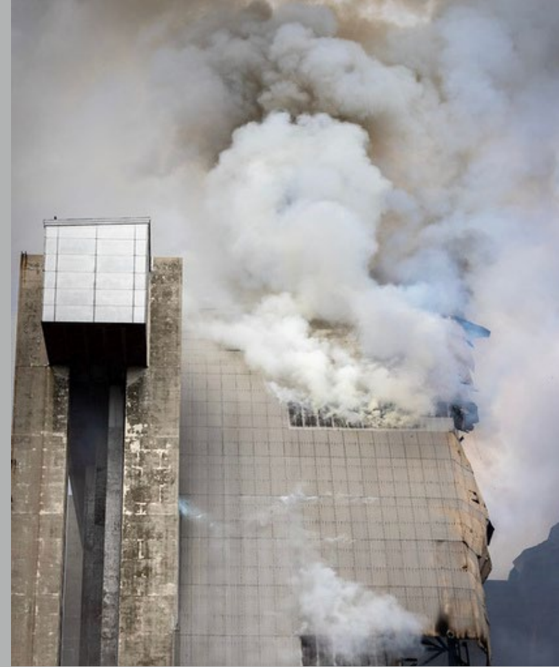
Tustin Hangar Fire (Nov 2023)
